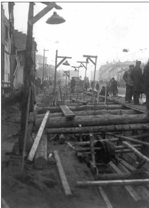
Строительство первой очереди
