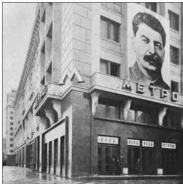
Наземный вестибюль станции «Охотный Ряд». Архитекторы А.В. Шусев, Л.И. Савельев, А.И. Старпан.
