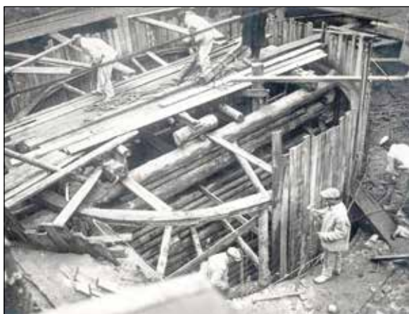
Шахта 18. Заготовка опалубки, кружал и арматуры воротника форшахты
