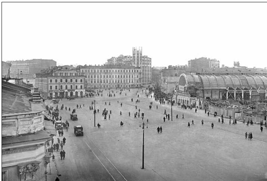
Строительство метрополитена на Арбатской площади
