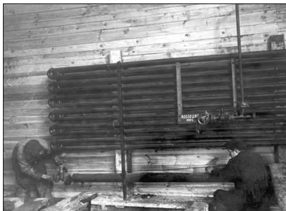
Монтаж оборудования для заморозки грунта
