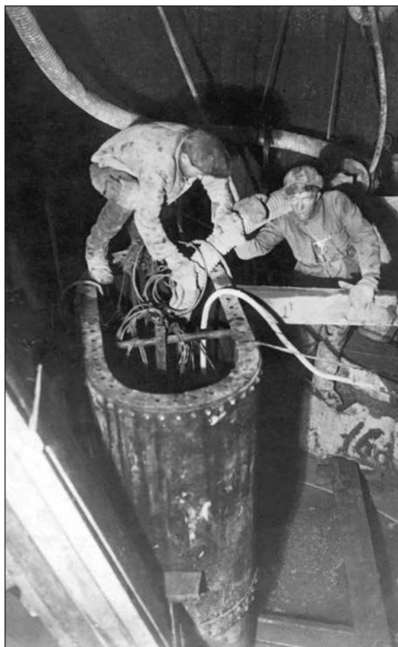
Установка кессонов в шахте
