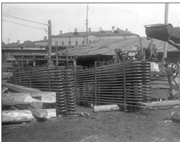
Оборудование для заморозки грунта
