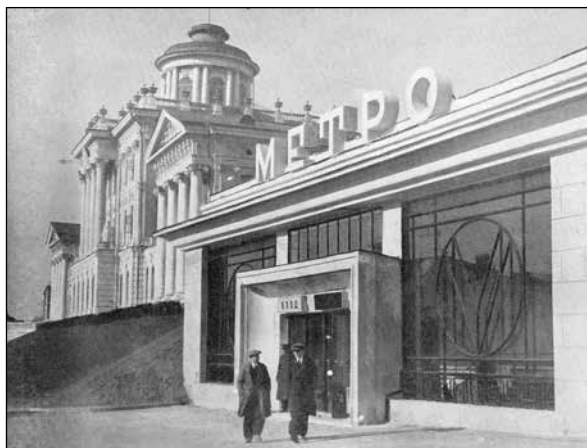
Наземный вестибюль станции метро «Библиотека имени Ленина» (не сохранился). Архитекторы С.М. Кравец, А.И. Соколов.
