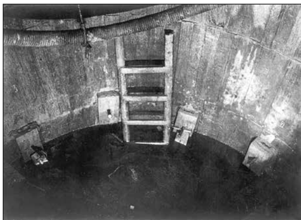
Затопленный ствол шахты
